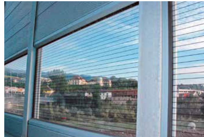
Noise barrier, Rederbrücke, Steyr PLEXIGLAS® Soundstop GS CC STRABAG-Thalgau, Forster Lärmschutz Elemente, Forster Metallbau Gesellschaft m.b.H.
